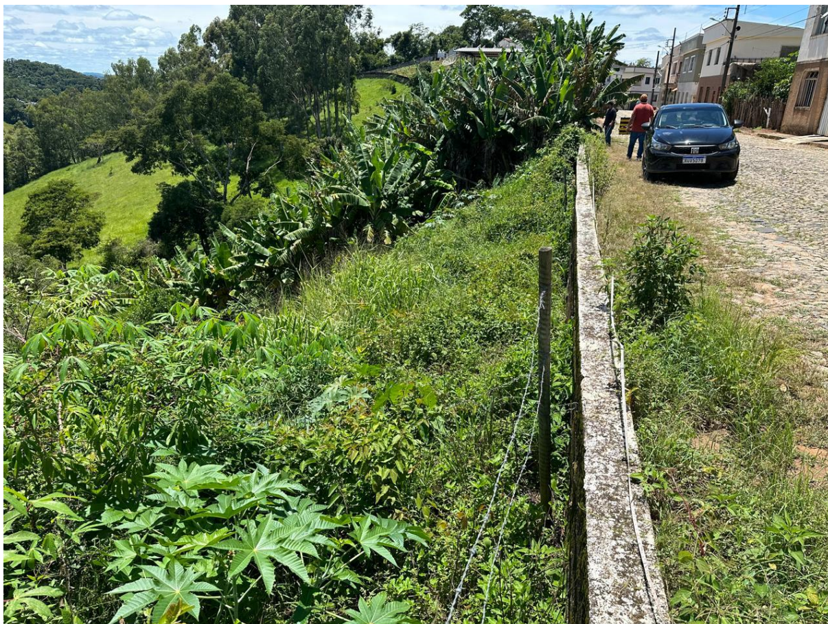
Local onde será executada o muro de arrimo e o reforço do muro de arrimo existente.
